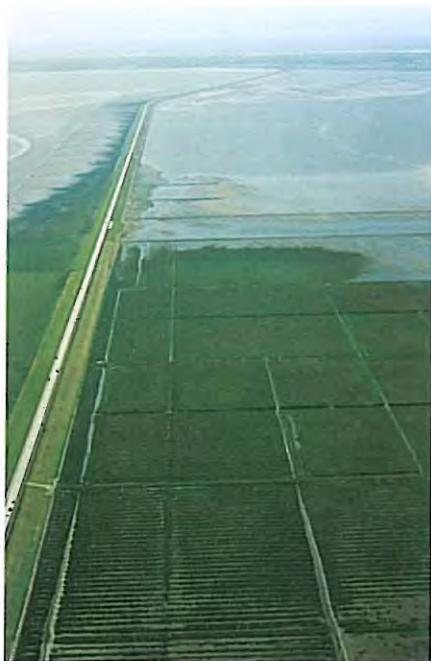
Langs Rømdæmningen foretages et intensivt landindvindingsarbejde for at sikre dæmningen. Foto S. Tougaard.
