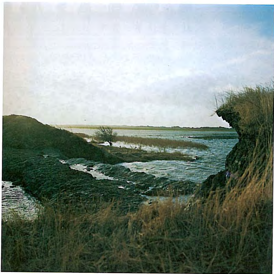
Juvrediget på Romø blev gennembrudt ved stormfloden den 3. jan. 1976.
