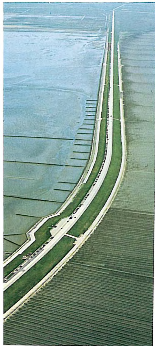
Fig. 12: Nogle steder f.eks. ved Rømdæmningen er det nødvendigt at groble og at sætte faskiner for at sikre dæmningen og digerne.
